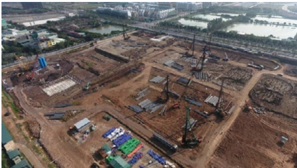
Nhà máy xử lý nước thải Yên Xá đang được đẩy nhanh tiến độ. Ảnh: Minh Anh
